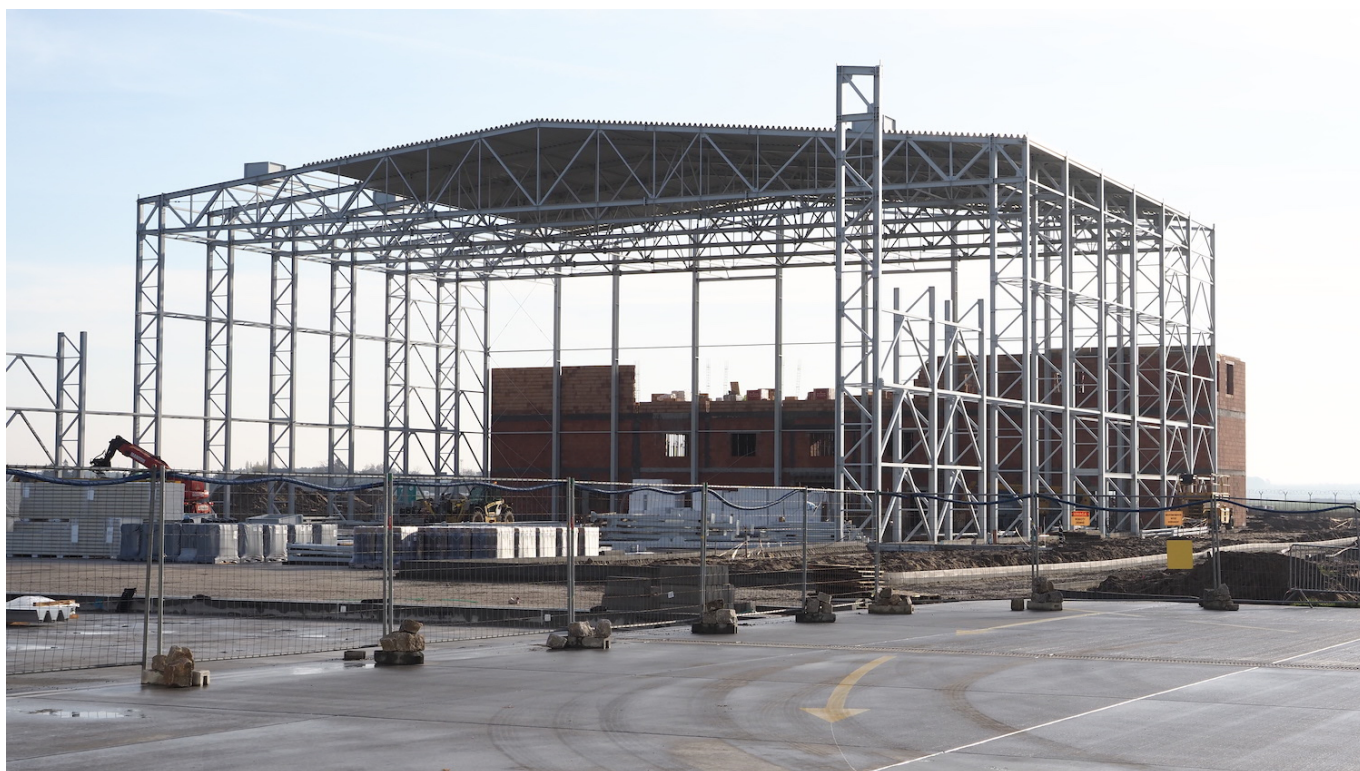
Stan obecny budowy. Fot. WZL Nr 2 S.A.
